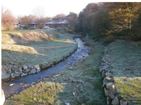
*Restauration de la continuité écologique, retalutage des berges pour recréer un lit avec un gabarit plus adapté au débit de basses eaux du cours d'eau au niveau du moulin de Saint Germain sur Ille (vue de l'Ille avant et après travaux)*
