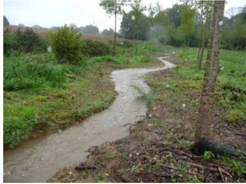
Reméandrage du ruisseau de la Chaussée à Gévezé (vue du ruisseau avant et après travaux)
